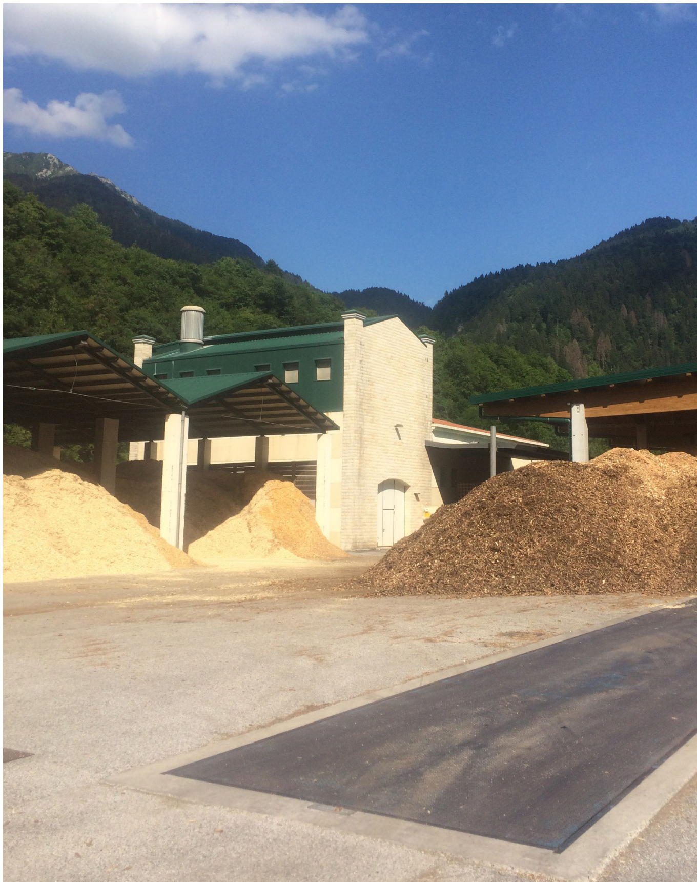
Centrale di teleriscaldamento di Arta Terme (UD) alimentata a cippato legnoso
